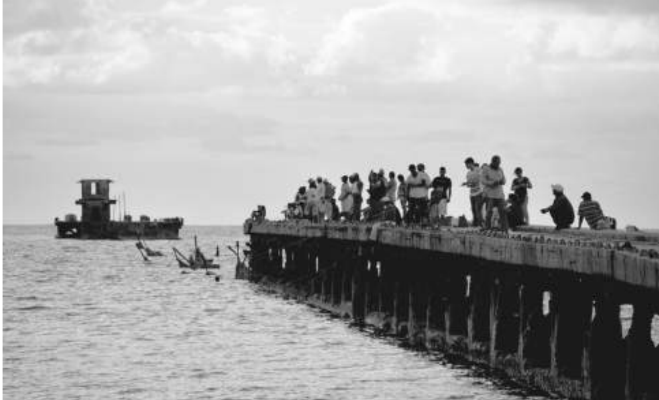
En julio de 2012, un tramo del muelle de Puerto Colombia colapsó. Fotografía de Rubén Darío Mejía.
