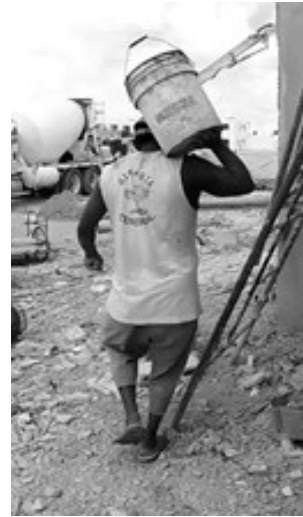
FIGURA 6. TRANSPORTE MANUAL DE CONCRETO (SUJETO 3).
