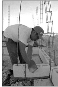
FIGURA 2. SUJECIÓN Y COLOCACIÓN DE BLOQUE DE CONCRETO EN MURO EN PRIMERAS FILAS (SUJETO 2).
