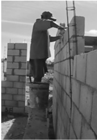
FIGURA 7. SUJECIÓN Y COLOCACIÓN DE BLOQUE DE CONCRETO EN MURO EN FILAS SUPERIORES (SUJETO 2).
