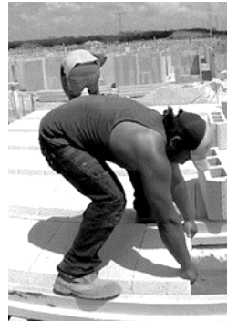
FIGURA 3. COLOCACIÓN DE BOVEDILLA EN TECHO (SUJETO 3).
