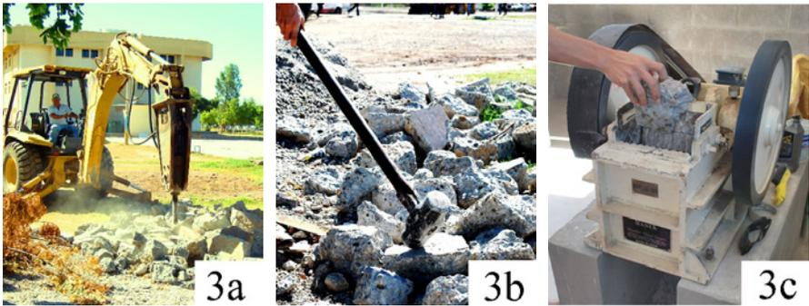
**Figura 3.** Proceso de trituración del hormigón de pavimento.
