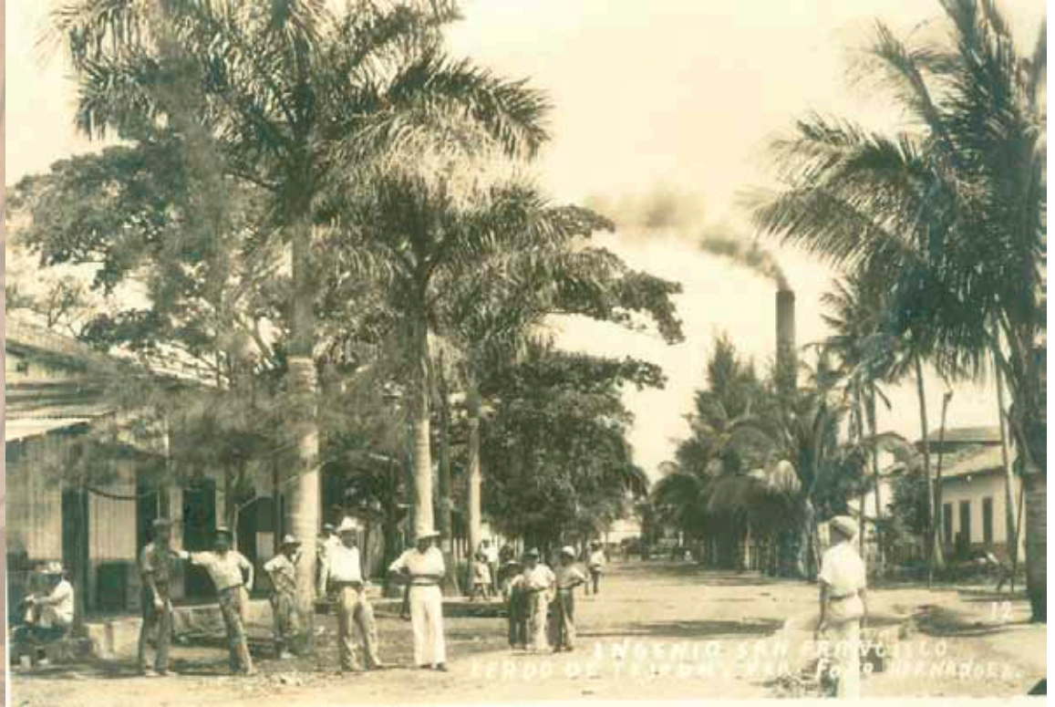
Imagen 21. Vista de la chimenea del ingenio San Francisco en Lerdo de Tejada, año 1925. Foto cortesía Archivo General del Estado de Veracruz (AGEV).
