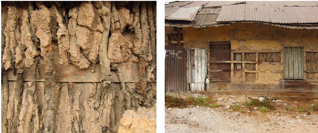
Figura 7. Construcción de Churqui y barro
