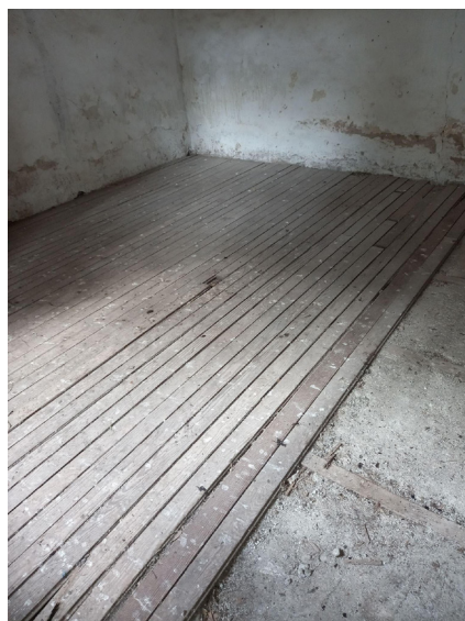
Figura 5. Piso de madera en una de las habitaciones de la casona de Monte Pelloni
