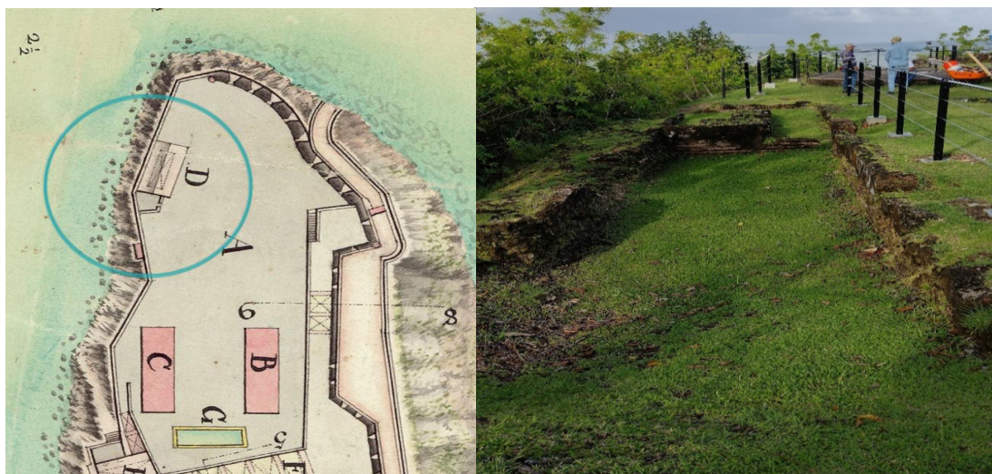
Figura 19. Almacén de pólvora
