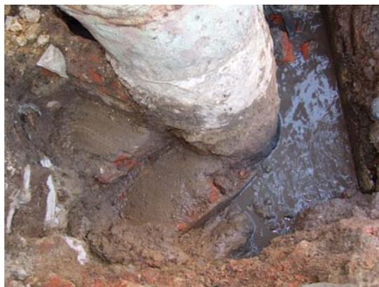
A 40cm de excavación se encontró un andén elaborado con ladrillos y mortero de cemento artesanal correspondiente a una época anterior. Para ese entonces el local donde actualmente funciona el servicio de baños no existía y el cañón se ubicaba en toda la esquina delimitando donde terminaba el andén, se evidenciaron tres entrepíes que facilitaban el acceso, pues el andén tenía 82 cm de altura y el nivel del agua permitía que las canoas atracaran y fueran amarradas al cañón.
