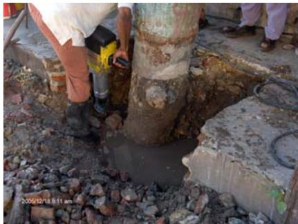
Debajo de la capa de concreto de 10cms se encontró uno de los muñones, tras 50cms de excavación fue necesaria la ayuda constante de una motobomba para evacuar la filtración de aguas servidas que se acumulaban de forma permanente en el pozo de excavación del cañón, lo cual hizo más dispendiosa la demolición.
