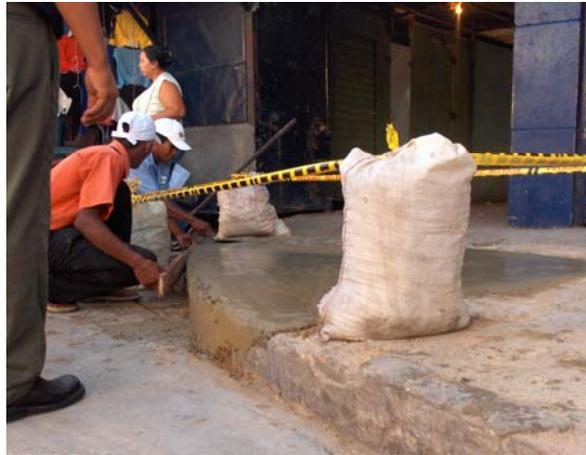
*Proceso de reconstrucción del andén Afectado con concreto 3000 psi y teniendo en cuenta las formas comprometidas.*
