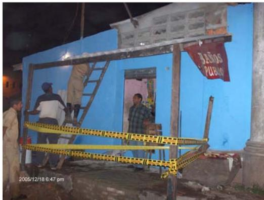
Luego se procedió a realizar el relleno para la reconstrucción del andén afectado por la excavación para la extracción, colocando ladrillos para lograr la altura que el andén tenía, terminar de pintar la fachada del local de Baños Públicos y volver a montar las tejas que fue necesario desmontar para que la grúa pudiera hacer la extracción.
