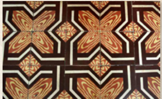
Figura 8: Imitación del “parquet” de madera en baldosas de cemento, mezclado lacería de líneas entrelazadas de influencia islámica. Estructura formal de repetición, activa e invisible. Se encuentra la forma como plano y como línea, en repetición de tamaño, dirección, textura, y espacio.
